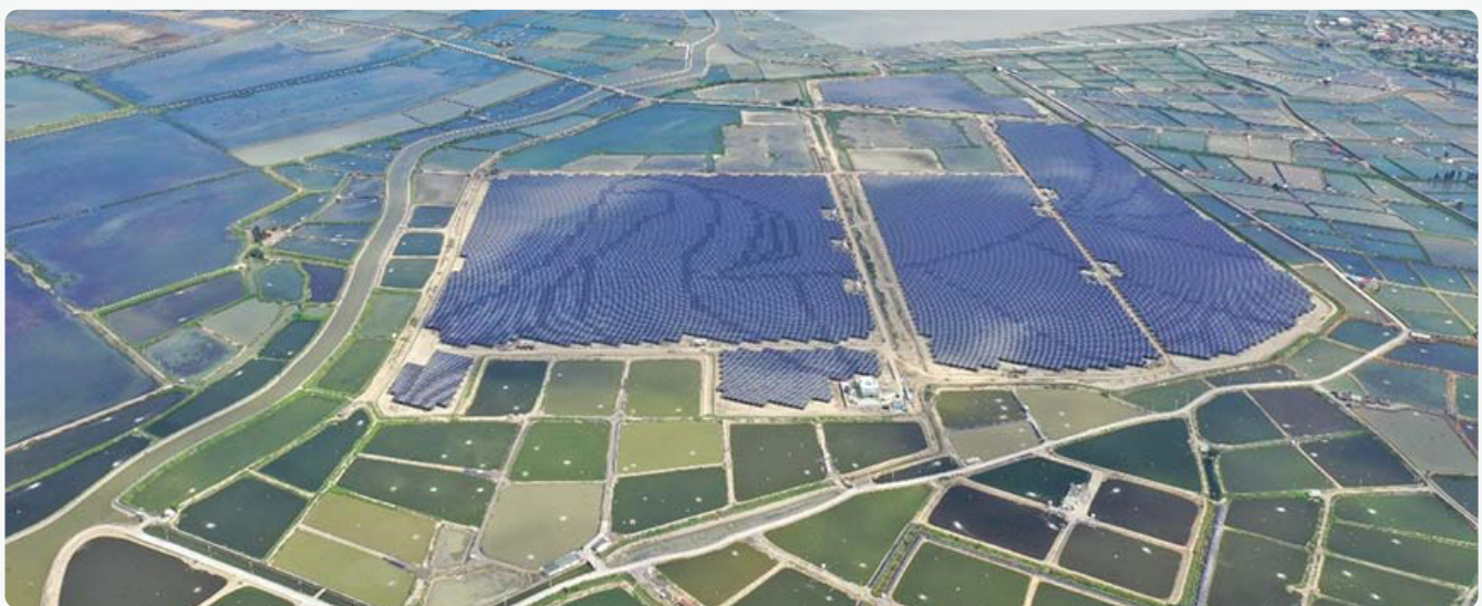
民國 109 年 5 月台灣首批再生能源轉供，嘉義鹽灘地太陽光電廠產出的電力正式送抵台積公司（照片來源：韋能能源）
