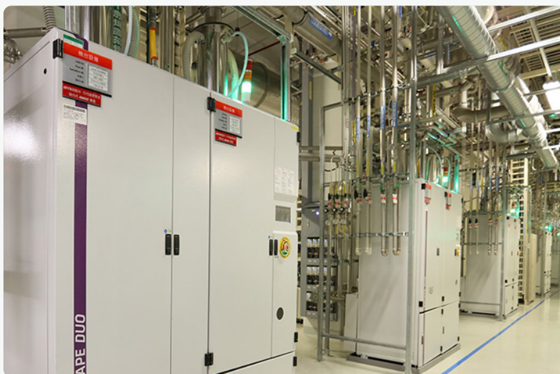
含氟溫室氣體現址式尾氣處理設備
